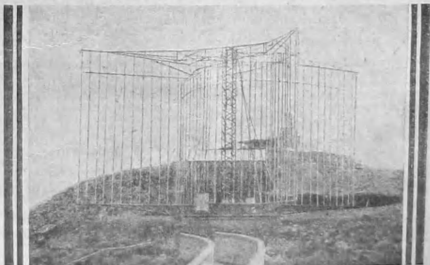
Рис. 5. Английская радиомаячная станция Маркони, дающая направленную с. заголовка этой статьи).
